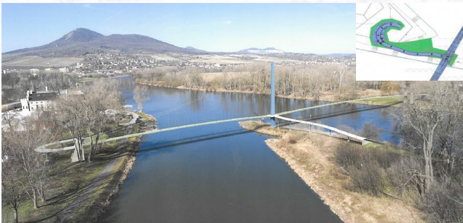
Dispozice lávky se sjezdem na Havraní ostrov (původní varianta). Ve výřezu je pak finální varianta po připomínkách CHKO.
