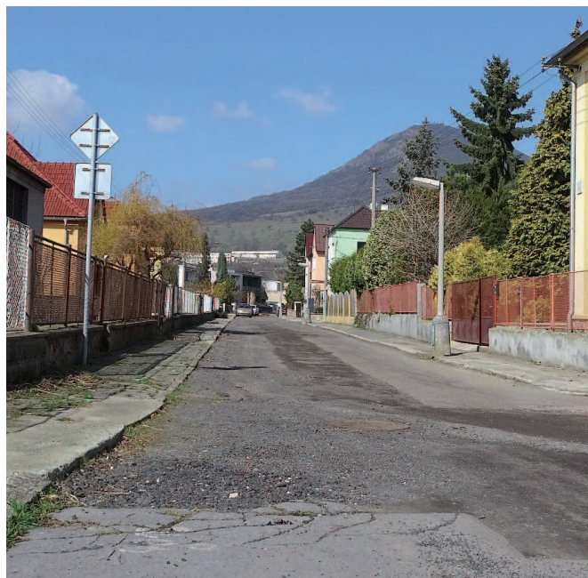
Opravy na Holoubkově začaly v ulici Dvořákova. O původu názvu Holoubkov čtěte na straně 13. Foto: Radim Tuček
