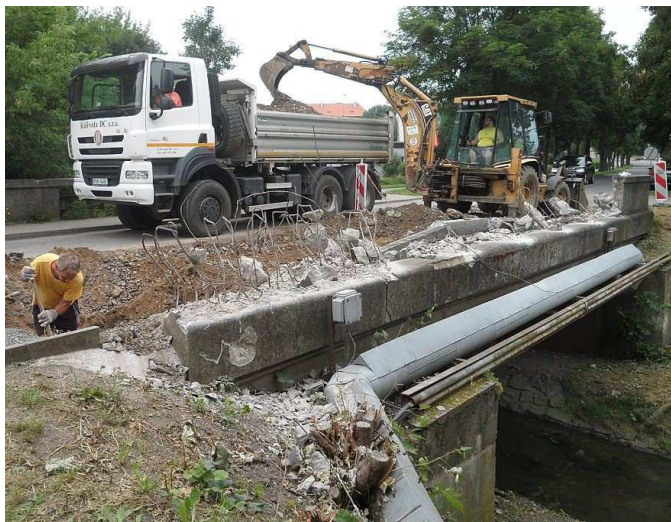
První stavbou, kde se začalo s opravami, je most v ulici Přívozní.
