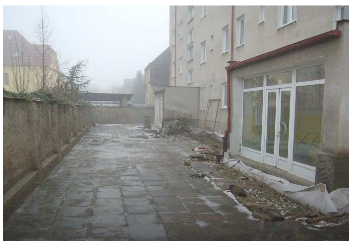
Současný stav dvora v DPS. Již zanedlouho začne další část rekonstrukce. (Foto: tuc)
