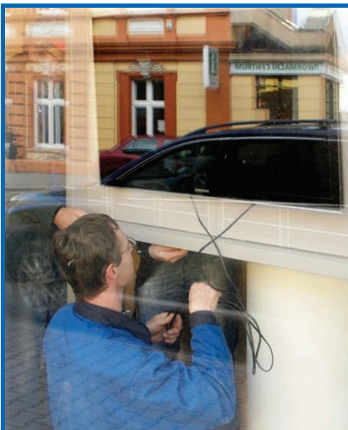
Instalace elektronického informačního panelu vedle vchodu MěÚ Lovosice Foto: hv
