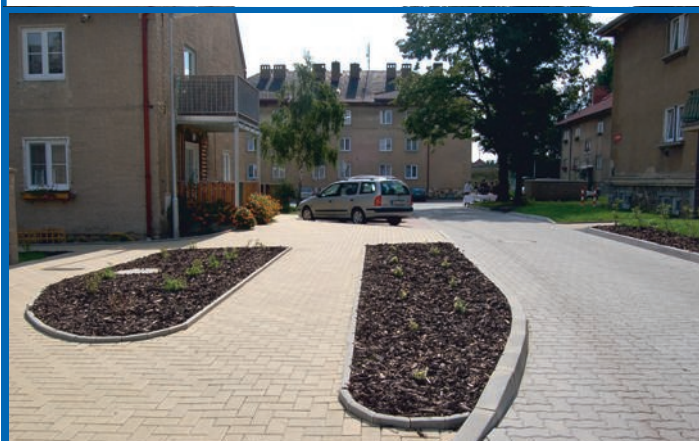
Slavnostní akt proběhl v opravené ulici U Nadjezdu
