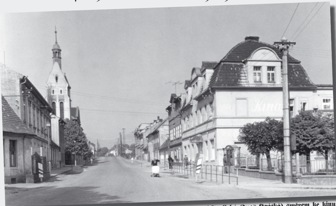
Záběr ze 60. let 20. století od bývalých železničních závor v ul. Teplická (dnes Krátká) směrem ke kinu. Vpravo se dochovávala budova učiliště, chemické průmyslovky a evangelického kostela vysvěceného v roce 1905. Budovy na levé straně byly zbourány v 70. letech 20. století. Přezila pouze budova dnes už bývalého kina. (Jan Mössler)
