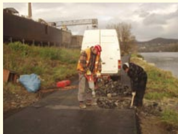
Poslední úpravy pod loděnicí na Lhotce. Dvakrát do roka se tu na vodu spouštějí nové lodě. V těchto místech musí být pro ně vyřešen sjezd.
