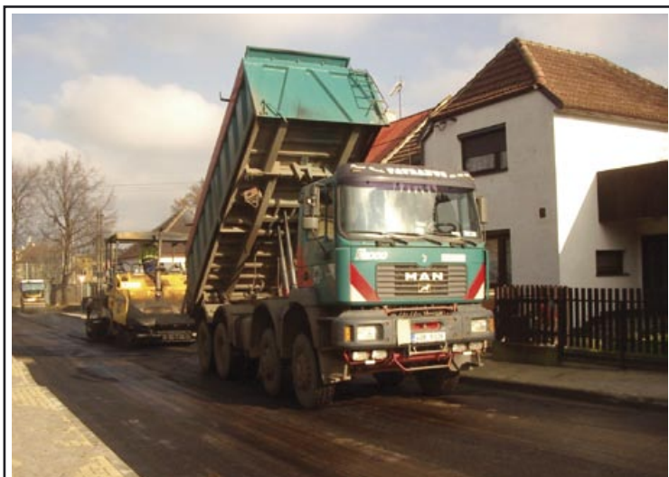
Rekonstrukce v Novém Klapý končí bez problémů. Dělníci vybudovali nové chodníky, veřejné osvětlení a kanalizaci. Vše by mělo být hotové do konce listopadu.
