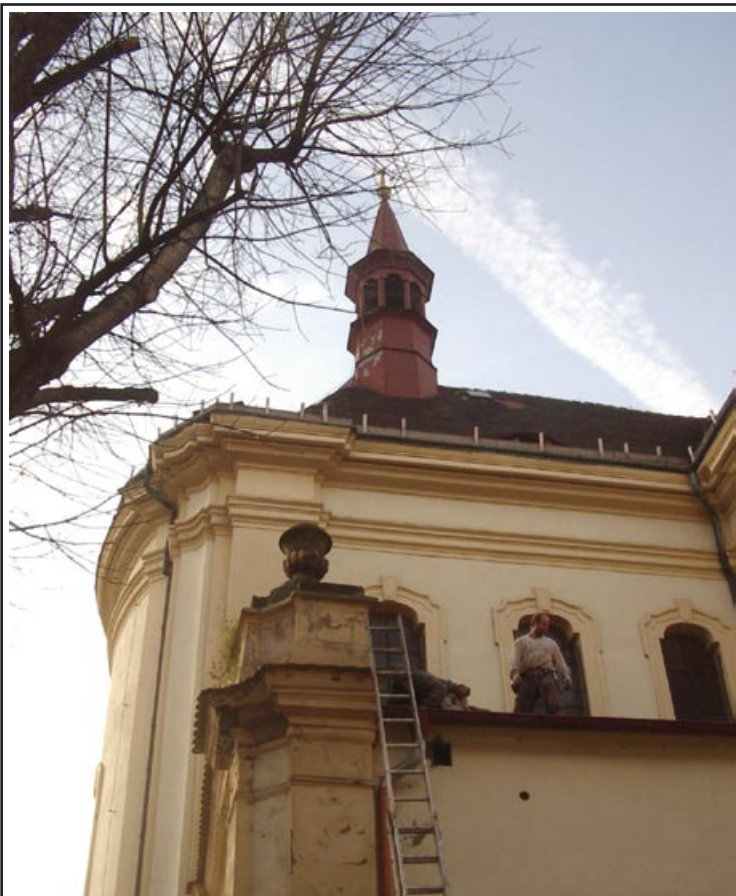
Střecha kostela sv. Václava se od 15. listopadu opravuje. Budovy kostelů patří všeobecně k architektonickým přednostem každého města. Jsou další nezbytnou podmínkou pro rozvoj cestovního ruchu. (as)
