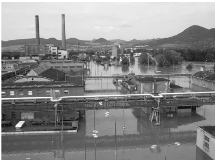
Povodeň 2002 v Lovochemii – součást zasažené lovosické průmyslové zóny.
