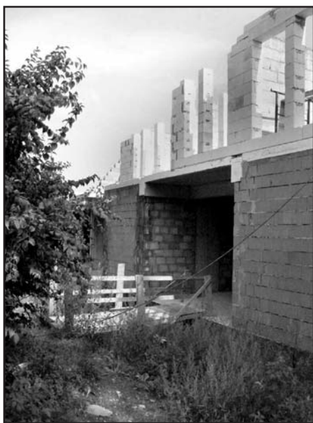
Také druhý obrázek dokumentuje přechodné zastavení práce na stavbě ORBISu. Ten plevel...
