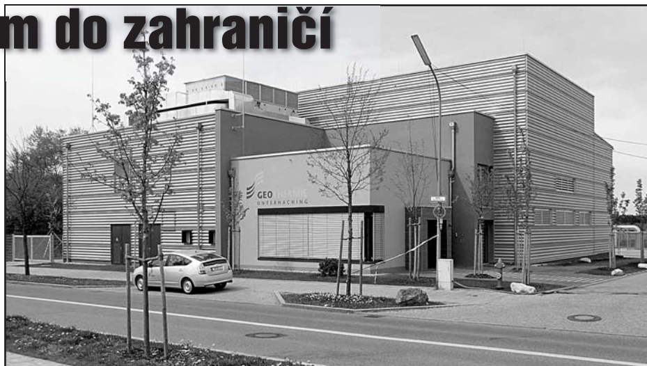
Geotermální elektrárna v Unterhachingu.
